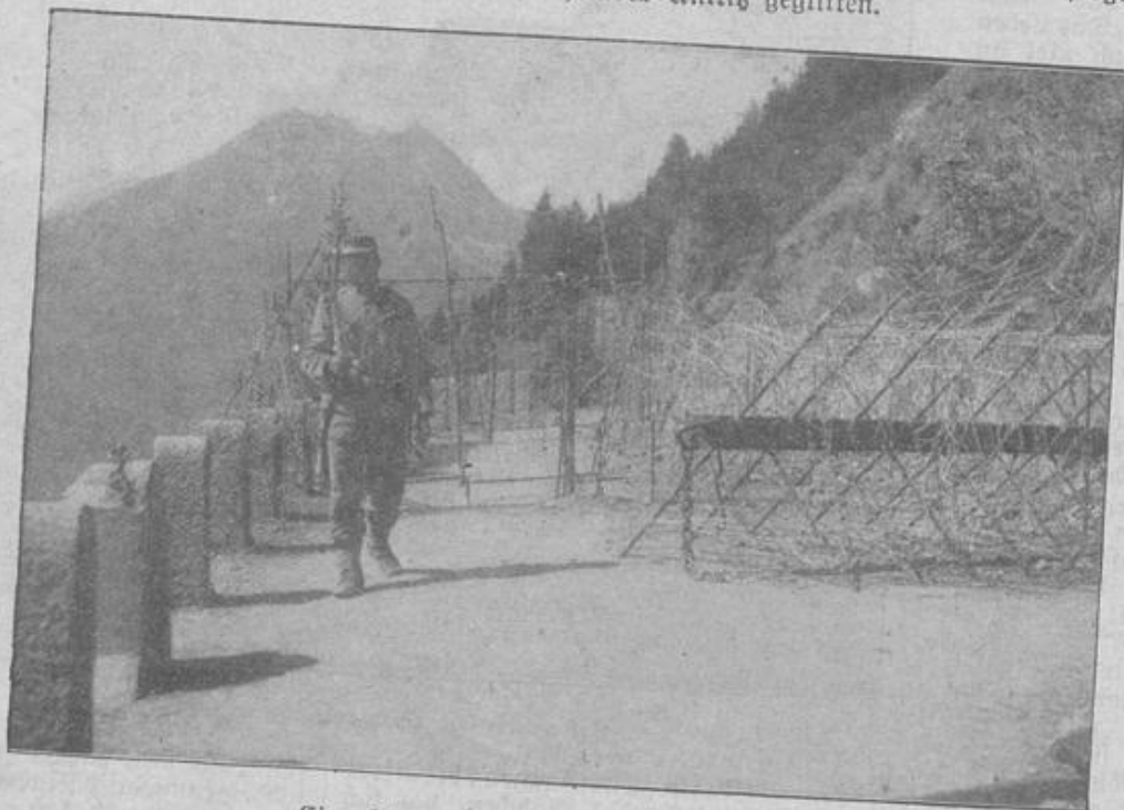
Eine Straßensperre auf dem Dolomitenpaß.
