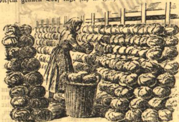
Abbildung 3. Koblischeune, von innen gesehen.
