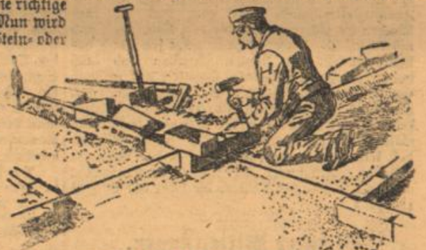
Abbildung 3. Das Setzen von Mauersteinen nach der Schnur.
