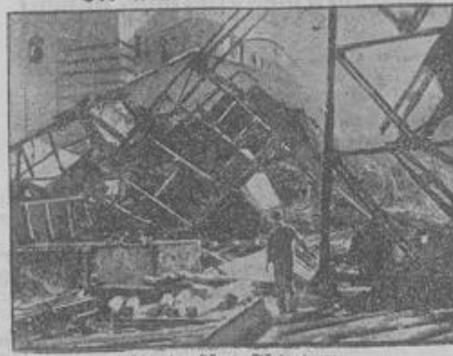
Der eingestürzte Förderurm.
