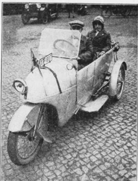
Ein neuartiges dreiräderiges Automobilfahrzeug, »Dixler« genannt. Das Auto hat einen 3,12 PS-Motor mit federloser Ventilsteuernng. (Sennede)
