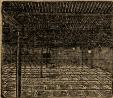
Bombirte Trägerwellblech-Decken, ausgeführt im Fabriketablisement von W. Spindler, Berlin und Spindlersfeld.
