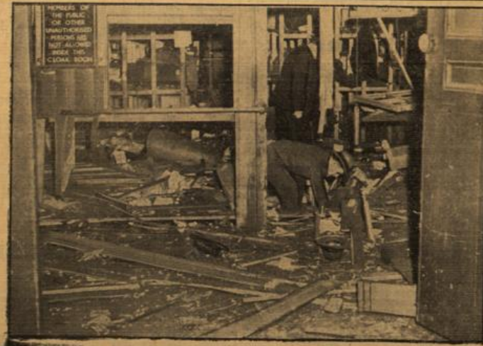
Burchbare Bombenexplosion in der Londoner Innenstadt.
