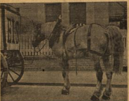
„Dieser“ steht allein auf der Straße. Der Fahrer hat sich in einen Schutzraum in Sicherheit gebracht.
