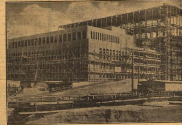
Am Mittelkanal wäscht die größte Autofabrik der Welt. Am Mittelkanal bei Hollersleben entsteht die größte Autofabrik der Welt , das deutsche Volkswagenwerk . Das Kraftwerk der Volkswagenfabrik , dessen Eigentum strukturiert ist und fertig ist , wurde schon zu zwei Drittel ausge-mauert . (Weltbild-Wagenberg-W.)
