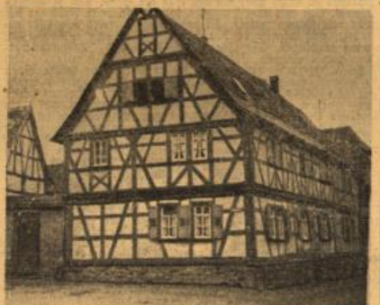
Mittelalterlicher, neu verputzter Fachwerkhau in der Vordergalle.
