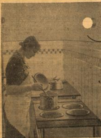
Für die Küchenbeleuchtung nicht eine Blendung hervorruftende halb höckerige Glühlampe, sondern eine geschlossene Opalglas-Leuchte für die Allgemeinbeleuchtung und Sonderleuchten an den beliebigen Arbeitsplätzen verwenden!
