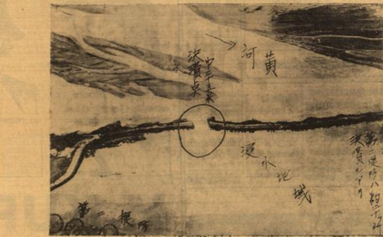
Hier brachen die Dämme des Gelben Flusses. Eine japanische Flugzeugaufnahme von den zerstörten Dämmen des Gelben Flusses, in dessen Kluten Zehntausende von Chinesen ertranken. Die Grundstellen des Hauptdamms und des Sicherheitsdamms sind durch Kreise gekennzeichnet. Durch sie nahmen die verpeetenden Wassermassen ihren Weg. (Weltbild, A.)
