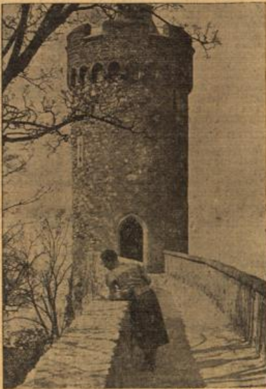
Die erneuerten Brüstungsmauern am Auerbacher Schloß. (Photo: Kern - W.)
