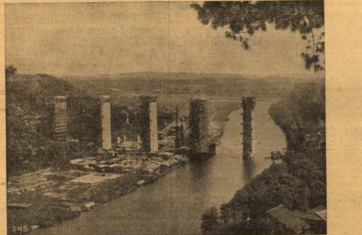
Fünf mächtige Pfeiler der Reichsautobahnbrücke über die Lahn sind bereits fertiggestellt. (D.N.B., Aufn. v. A. Kern.)
