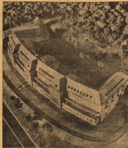
Bau einer Gesundheitsburg in Bagreth.
