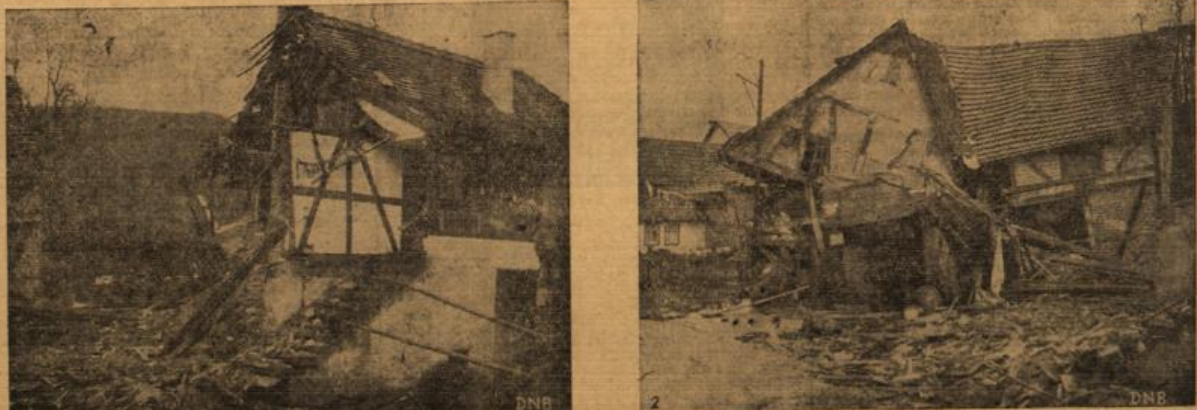
Mit 100-120 Stundenkilometer Geschwindigkeit durchbrach der Lastkraftwagen das Wohnhaus, raste dann quer über die Dorfstraße und kam erst in einer über ihm zusammenbrechenden Scheune zum Stehen. Bild 1: Das zertrümmerte Haus des Schneidermeisters Schumann. Bild 2: Die Scheune des Landwirtes Siedling, der Lastwagen ist vollständig, der Anhänger zur Hälfte von dem eingestürzten Gebäude verdeckt.
