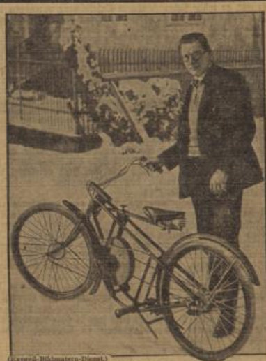
Ein Reit-Fahrad. Ein Mechaniker in Klingling am Chiemsee hat ein Kraft- und erfunden, das nicht von einem Motor, sondern nur durch das Eigengewicht des Fahrers angetrieben wird. Durch Heben und Senken des Oberkörpers wird der freischwebende Sattel auf und nieder bewegt, der dann über eine Pleuellange ein mit dem Hinterrad gekoppeltes Schwungrad in Umdrehung versetzt. Mit diesem Rad hat sein Erfinder die Geschwindigkeit von 40 Kilometer in der Stunde erreicht.
