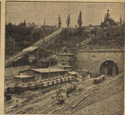
Die Reichsbahn führt durch einen Tunnel.
