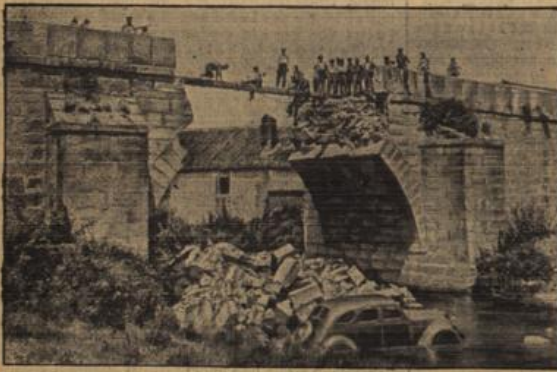
Um den weiteren Vormarsch der Truppen der Militärregierung auf Madrid aufzuhalten, haben die Truppen der Volksregierung die strategisch wichtige Brücke über den Guadarrama-Fluß gesprengt.
