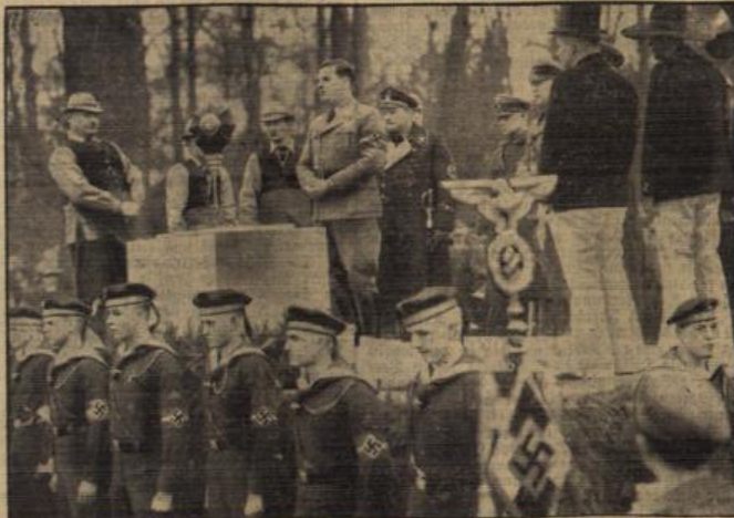
Hier entsteht die Akademie für Jugendführung.
