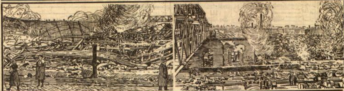
Großfeuer im Siemens-Schuckert-Kabelwerk „Gartenfeld“ zwischen Spandau und Haselhorst am Spandauer Schiffahrtskanal. Die vollständig zerstörte Kloppelei und Spinneret.
