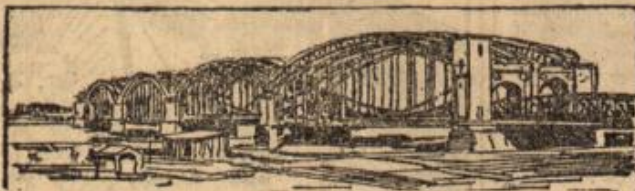
Die neue Elbbrücke bei Garburg, 625 Meter lang. Baukosten 31,2 Millionen Mark.
