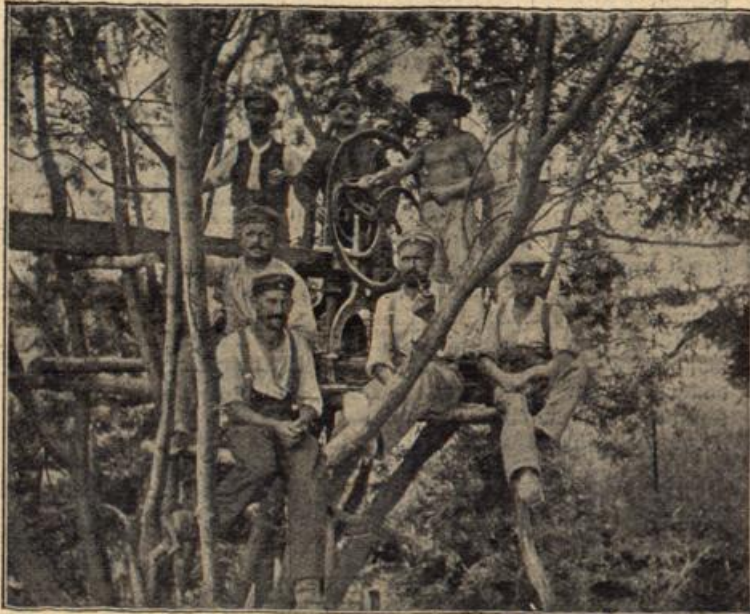
Pumpvorrichtung zum Entwässern und Trockenhalten von Schützengräben.
