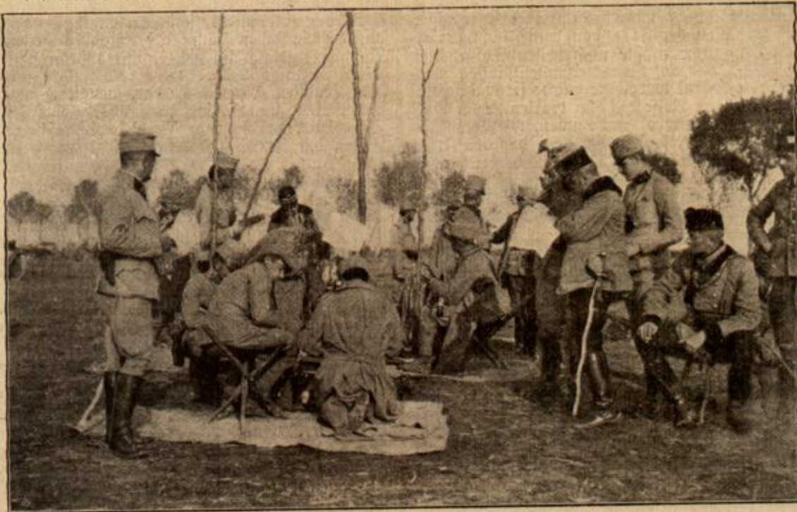
Eine österreichisch-ungarische Korps-Telephon-Station. (Mit Text.) Phot. C. Seebald, Wien.
