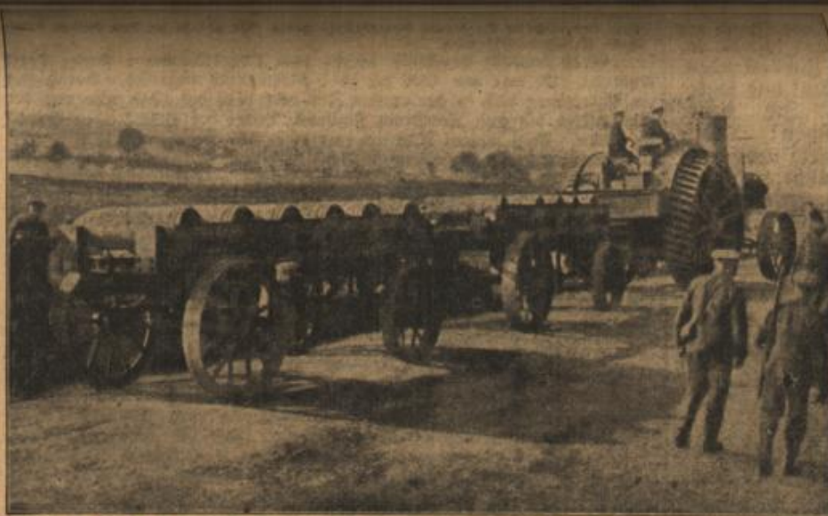
Von der Westfront: Großkalibrige englische Geschosse werden mittels Straßenlokomobile befördert.
