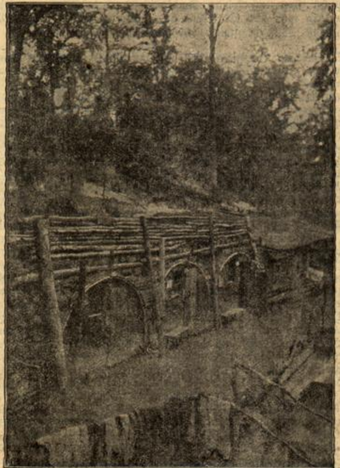
Unterhandsbauten im Walde: Die Villa des Stabes.
