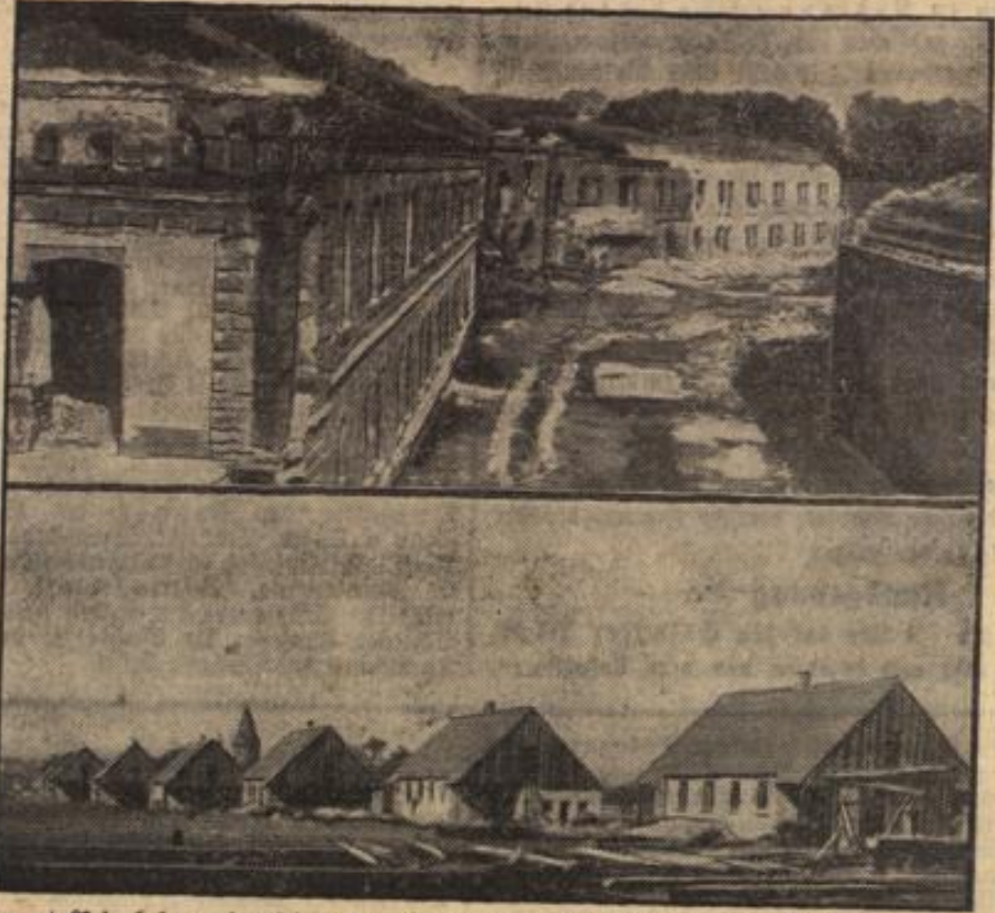
Oben: Das Fort Viehler (zwischen Erbenheim und Kastel) während Abruchsarbeiten. — Unten: Die Stadtrand siedlung Viehler, die zu 95 Prozent aus dem Material des ehemaligen Forts errichtet wurde.
