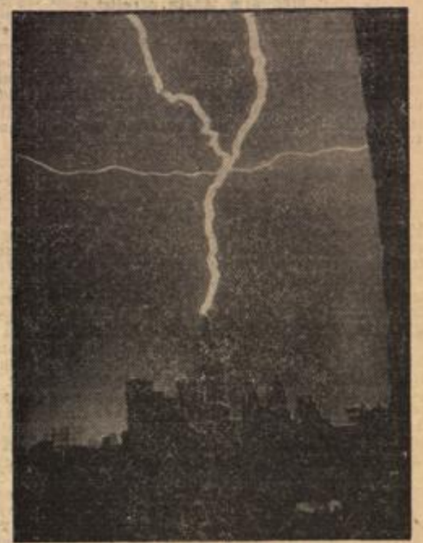
Das höchste Gebäude der Welt als Blitzableiter. Eine Zufalls-Aufnahme vom Einschlag eines gabelförmigen Blitzes in das Empire-State-Building in New York, das höchste Gebäude der Welt. Durch einen Blitzableiter wurde der Riesebau, der natürlich bei Gewittern besonders bedroht ist, vor Schaden bewahrt.
