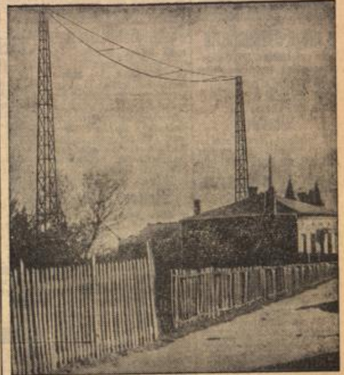
Blick auf die Sendestation Toulouse (Süd-Frankreich).
