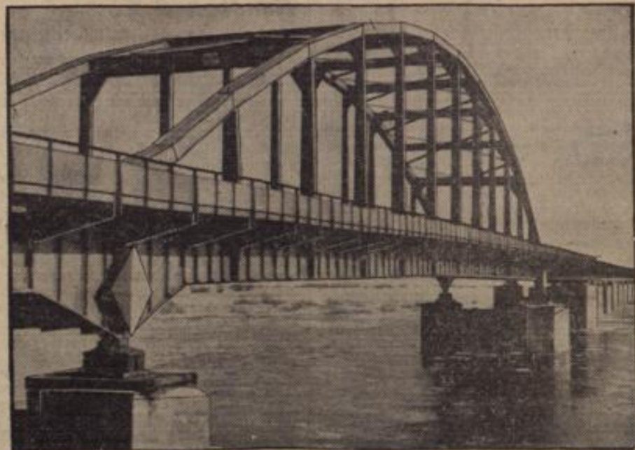
Die neue Tangermünder Elbbrücke.
