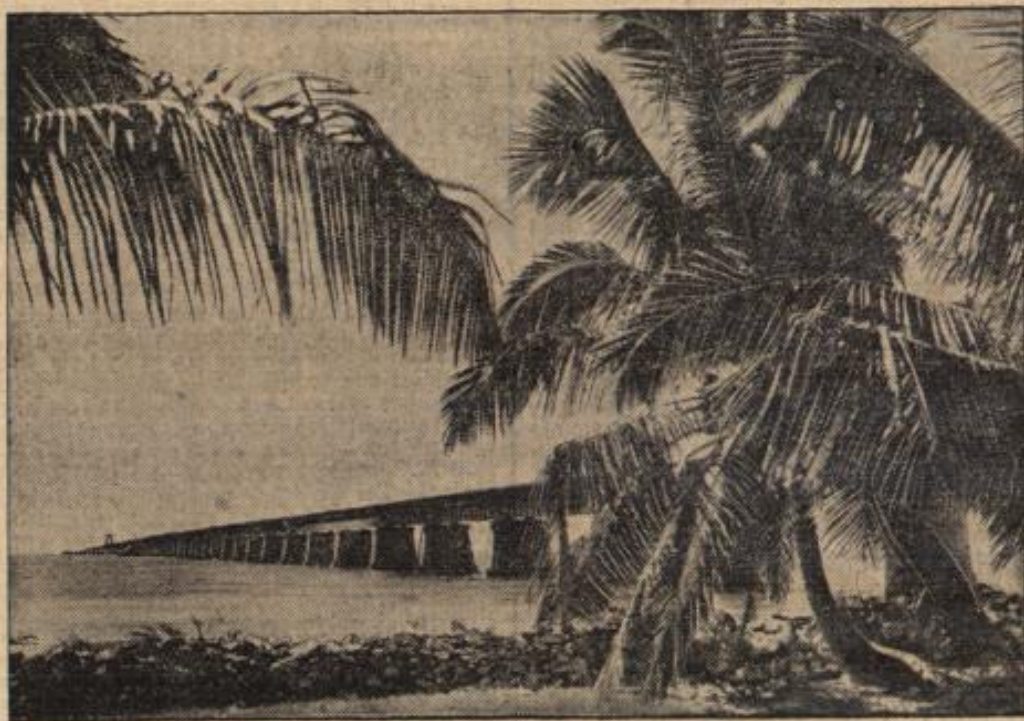
Die längste Eisenbahnbrücke über den Ozean.
