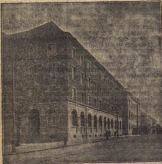
Neubau des Regierungsgebäudes.
