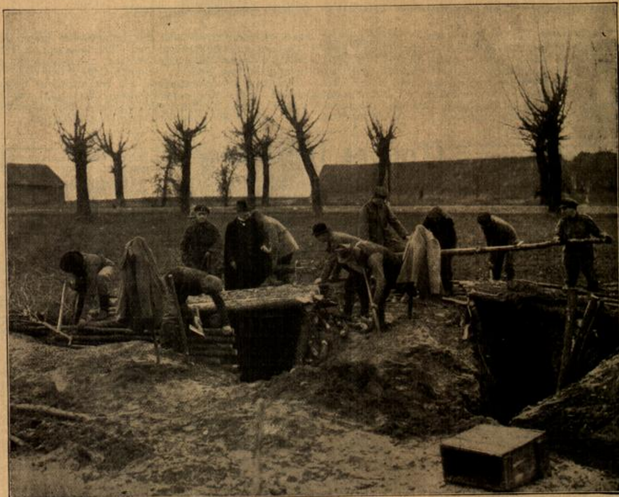
Der unausgebildete Landsturm beim Bau von bombensicheren Unterständen auf dem östlichen Kriegsschauplatz.
