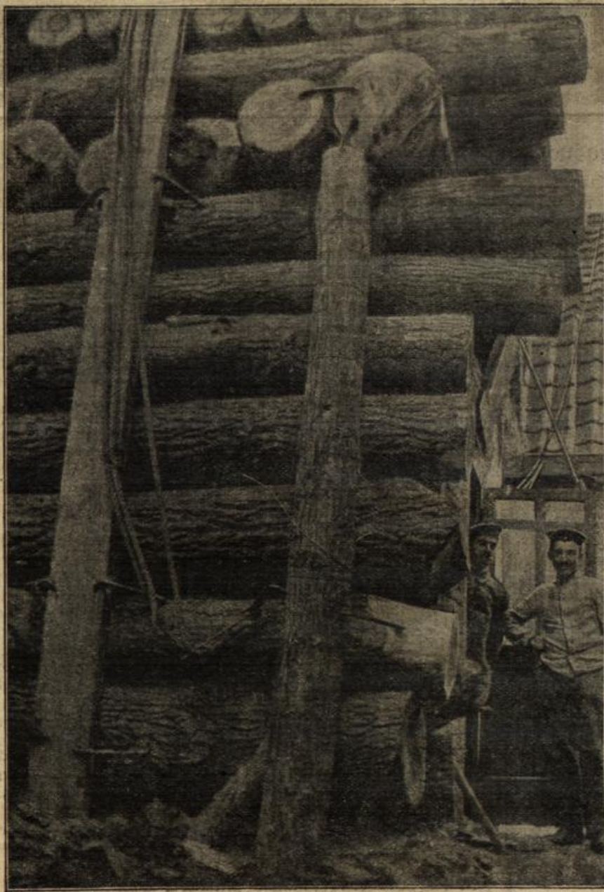
Sicherung eines Zernsprech-Unterstandes an der Adne-Linie.
