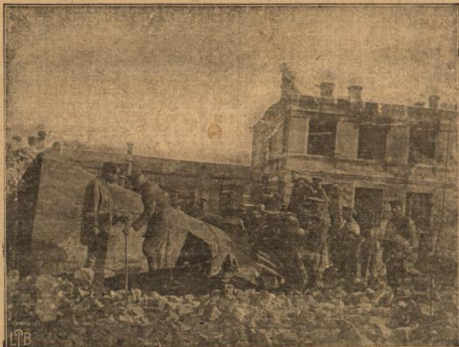
Deutsche Soldaten und gefangene Russen bei der Instandsetzung der zerstörten Wasserleitung in Bialystok.
