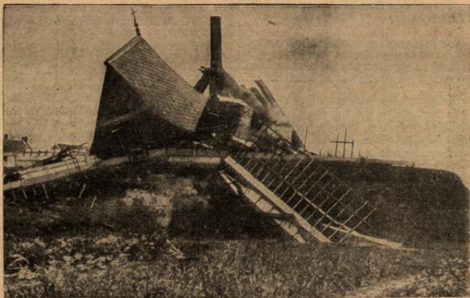
Die zerstörte verräterische Windmühle.
