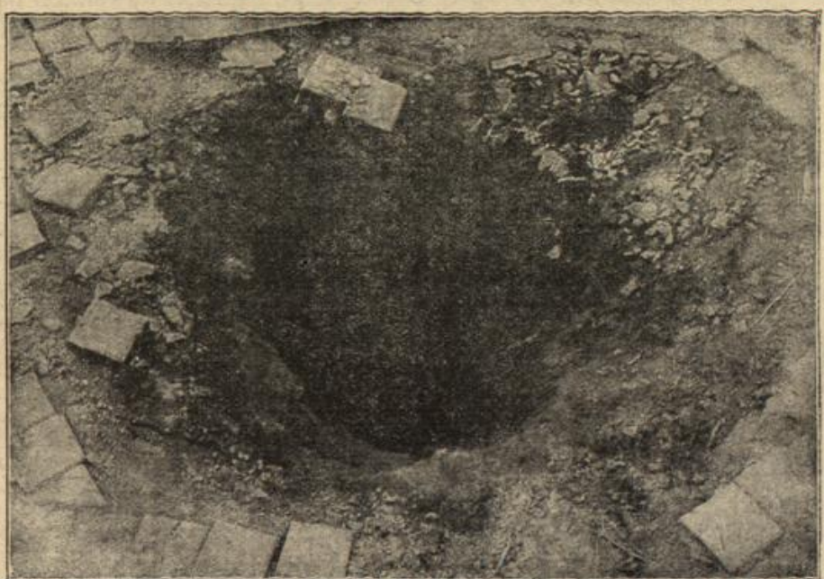
Von den Kämpfen an der Westfront: Einschlag eines feindlichen 30,5-cm-Blindgängers. Das Granatloch hat eine Tiefe von 8 Metern.
