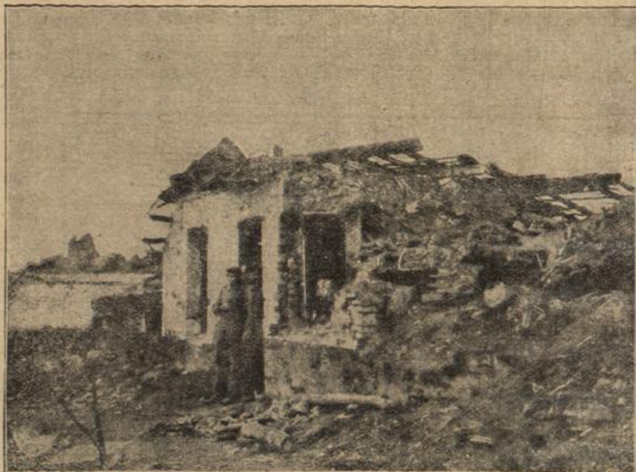
Unterstandseingang durch ein zerstörtes Haus auf dem westlichen Kriegshauptplatz.
