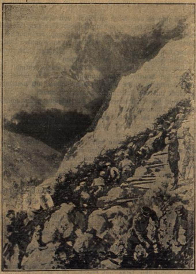
Vom österreich-italienischen Kriegsschauplatz. Italiener bauen auf einem Abhang Schützengräben und verdecken diese mit Zweigen.
