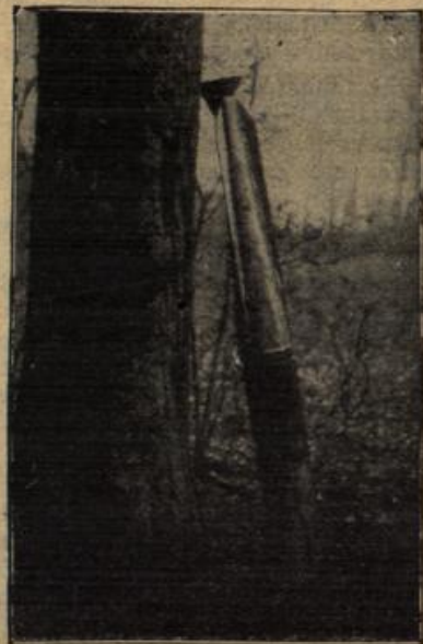
Bei Neß abgeworfene nicht krepierete französische Fliegerbombe. Am oberen Teil ist eine Blechführung mit Trichter angebracht. Gesamthöhe 1,65 m, Gewicht 40 kg.
