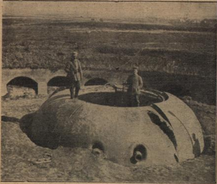
Zu den Kämpfen im Westen: Ein Panzerturm, der von einem Schuß unserer schweren Geschütze völlig zertrümmert wurde.
