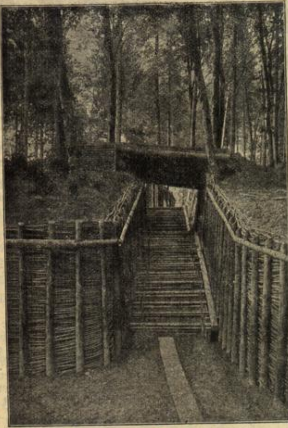
Der Grenzschutz der Schweiz. Vorbereitete Batteriestellung, in der die Geschütze auf verschiedenen Höhen liegen.
