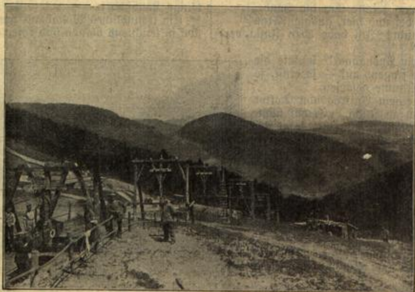
Drahtseilbahn zur Beförderung von Verwundeten aus den Höhenstellungen.
