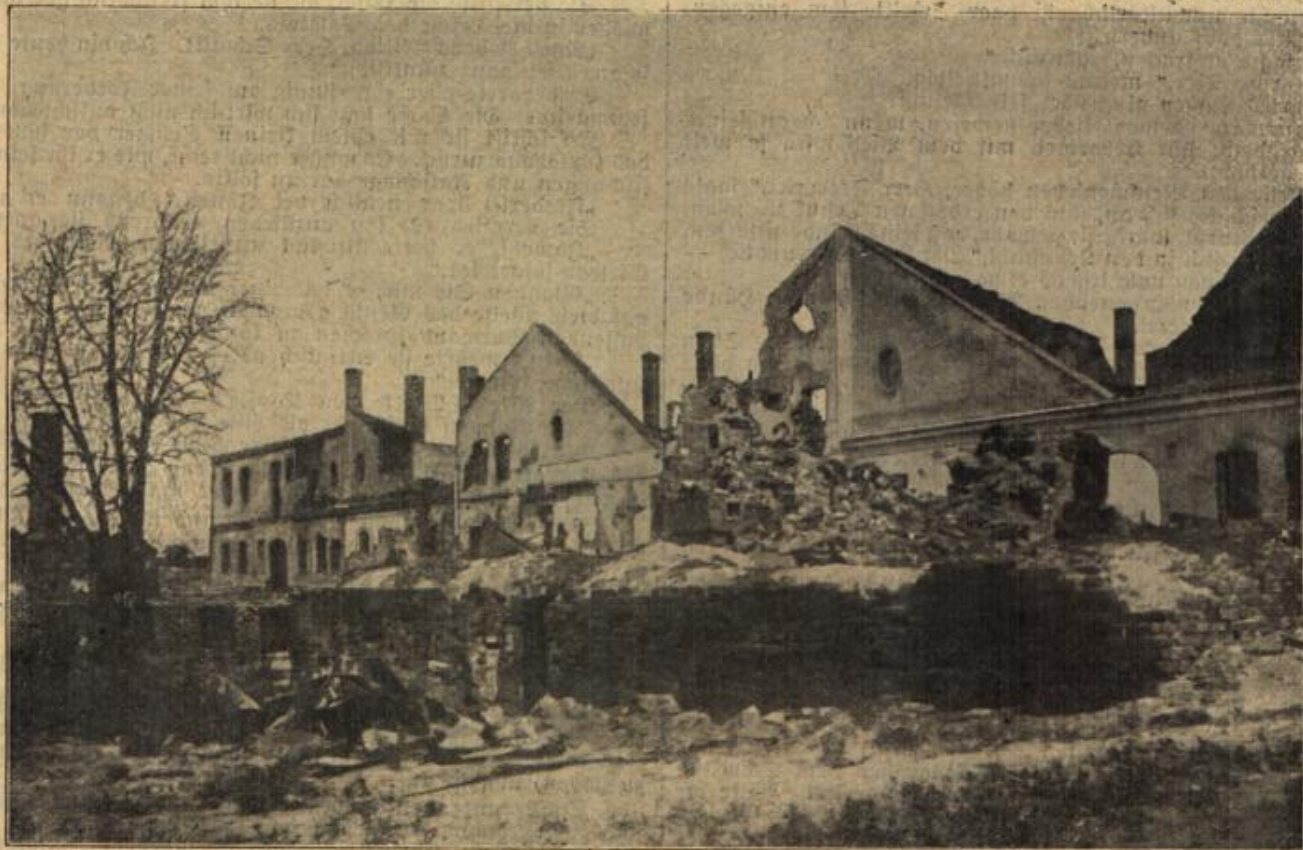
Ein zerstörtes Stadtteil von Lublin.
