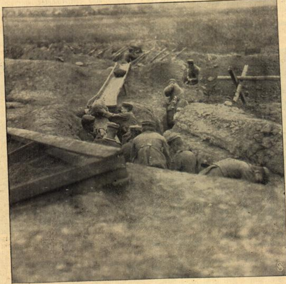
Transport von Sandsäcken in einem eroberten Schützengraben.
