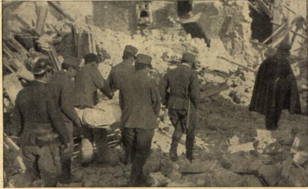
Kettungsarbeiten der Soldaten und Feuerwehrlente in Sora.
