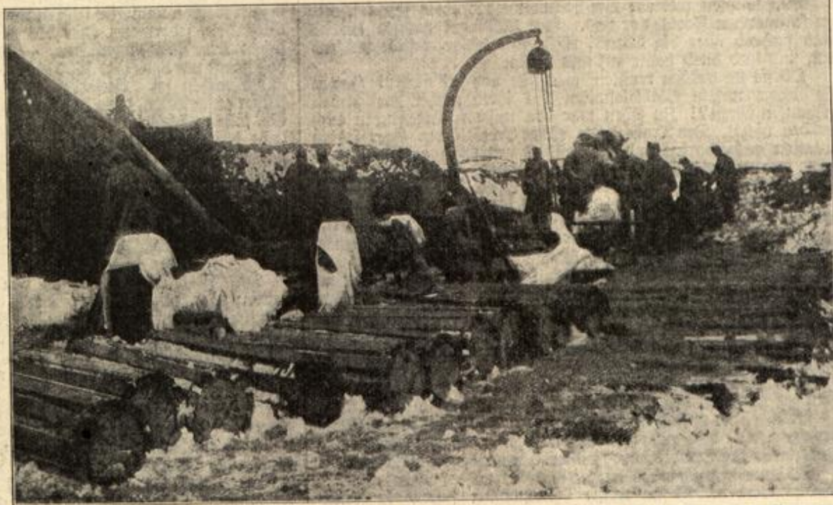
Vom Kriegsschauplatz in Ungarn: Österr.-ungar. 30,5 cm-Mörser mit Hebelkran für fast mannshohe Granaten. Im Vordergrund Munitionsvorrat. Die weißen Tücher dienen zur Bedeckung gegen Fliegerlicht. Phot. Klopshot, Wien.
