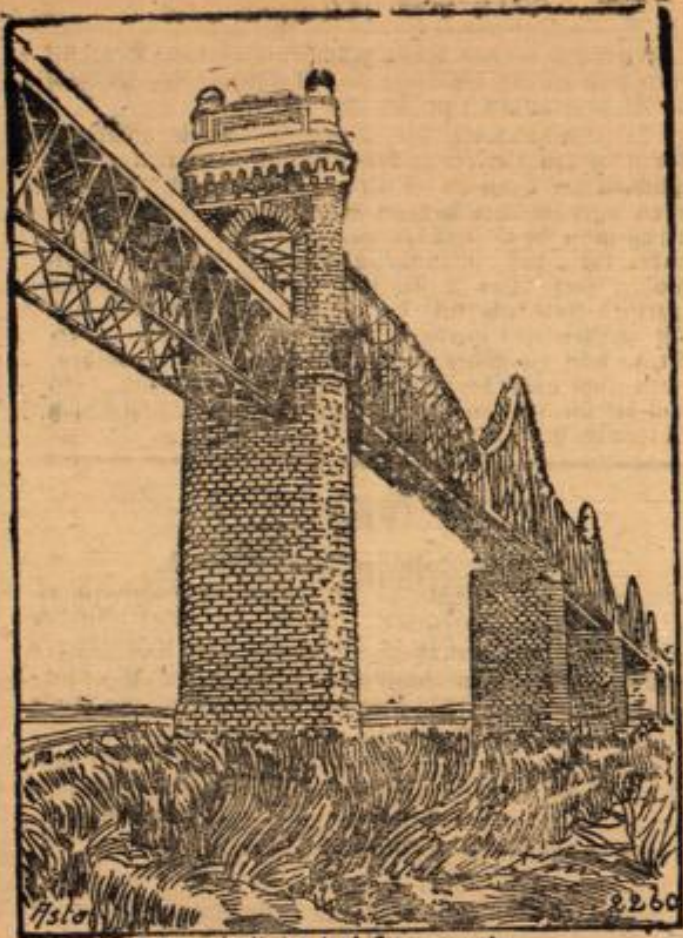
Donaubrücke bei Cernavoda.
