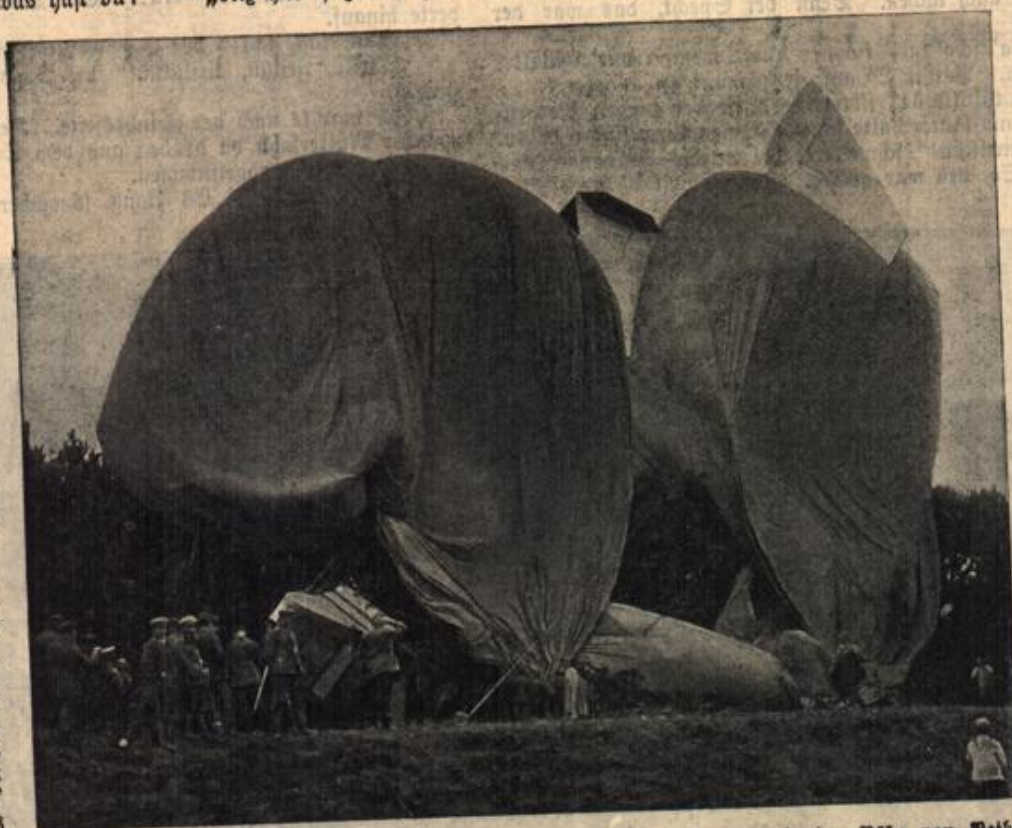
Das französische Luftschiff „Alsace“, das von den deutschen Truppen in der Nähe von Reihel heruntergeschossen wurde. Von der französischen Heeresverwaltung erst während des Krieges fertiggestellt, besaß es eine Länge von 180 Metern und einen größten Durchmesser von 19 Metern; die Gesamthöhe betrug 23 Meter. Das Vorderstück des bei einer nächtlichen Fahrt getroffenen Luftschiffs zeigte mehrere Schußstellen, die Gondel war in der Mitte entzweigebrochen. Das Luftschiff versank in einem Tannenwald, wo es von deutschen Soldaten erbeutet wurde. Die 8 Mann Besatzung wurden gefangen.
