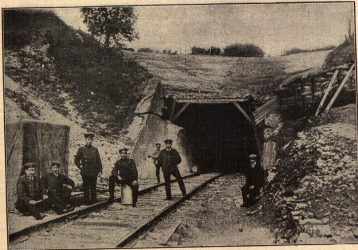
Ein belgischer Eisenbahntunnel, der seinerzeit von den Belgiern zwecks Behinderung der deutschen Bahntransporte zerstört, von den Deutschen aber alsbald wieder hergestellt wurde und nun längst wieder in Benutzung genommen ist.
